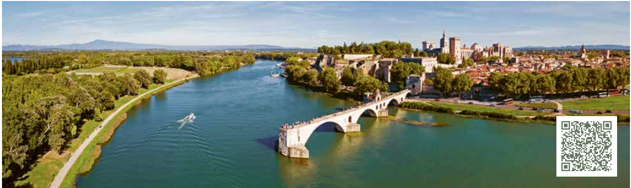
BRÜCKE SAINT-BÉNÉZET, AVIGNON
