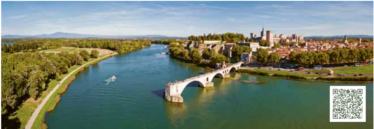
SAINT-BÉNÉZET BRIDGE, AVIGNON
