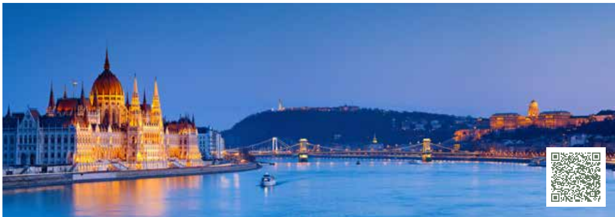
PARLAMENTSGEBÄUDE UND KETTENBRÜCKE, BUDAPEST
